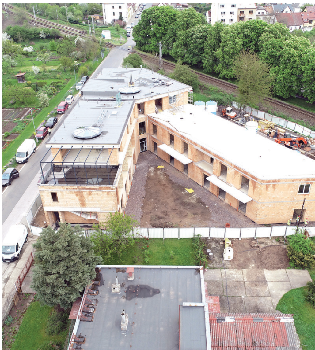
Stavba odlehčovací služby v Honkově ulici, která byla zahájena v květnu loňského roku, zatím pokračuje podle plánu. Aktuálně stavbaři ukončují práce na osazení venkovních výplní otvorů a zahájili práce na venkovních fasádách. // Foto: Archiv MMHK, Pavel Struha
